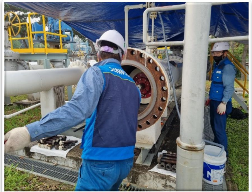
Disk Pig (Brush) 장착
