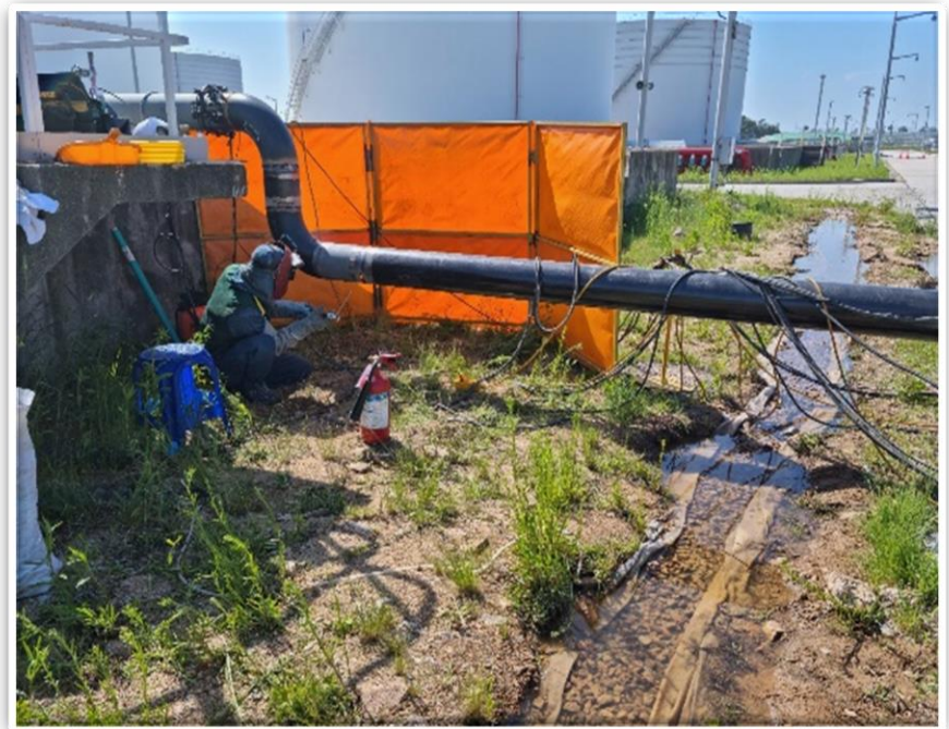
임시배관 설치 작업
