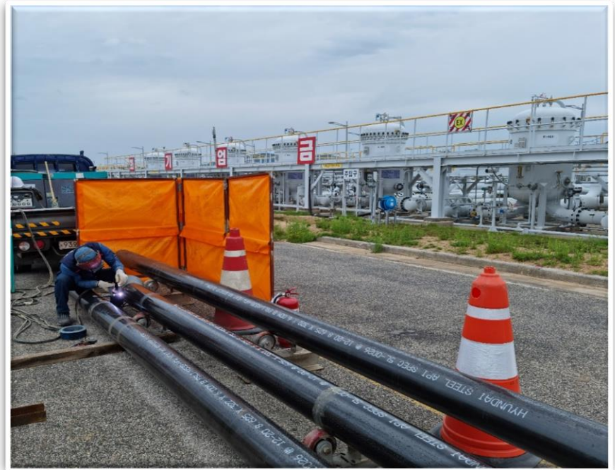
임시배관 설치 작업
