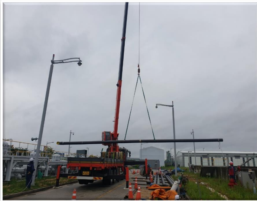
임시배관 설치 작업
