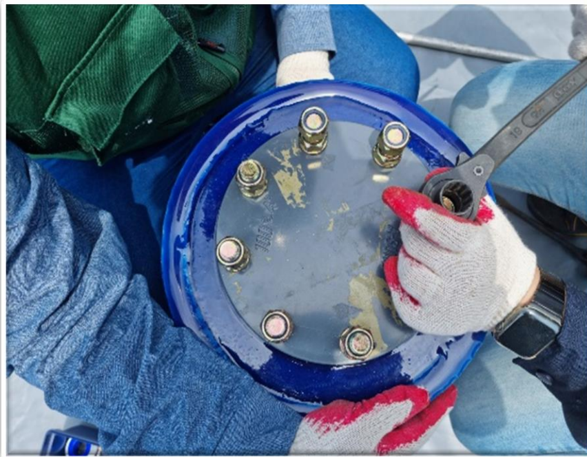
Transmitter 장착
