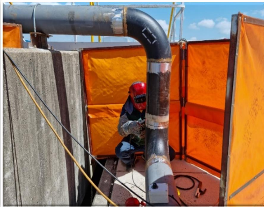
임시배관 설치 작업
