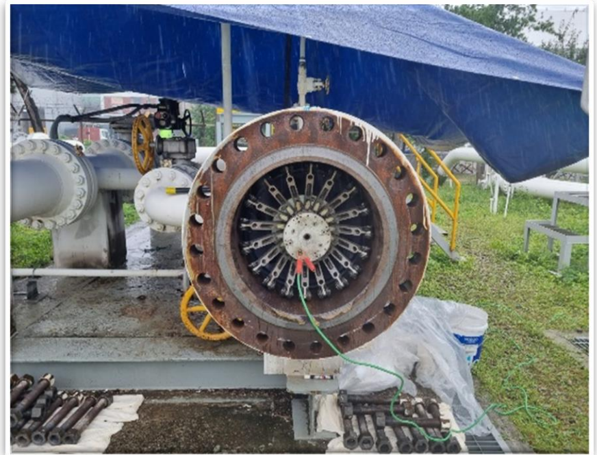
Geometry 장착
