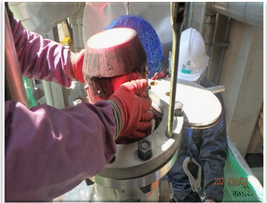
Metal Pin Pig 회수
