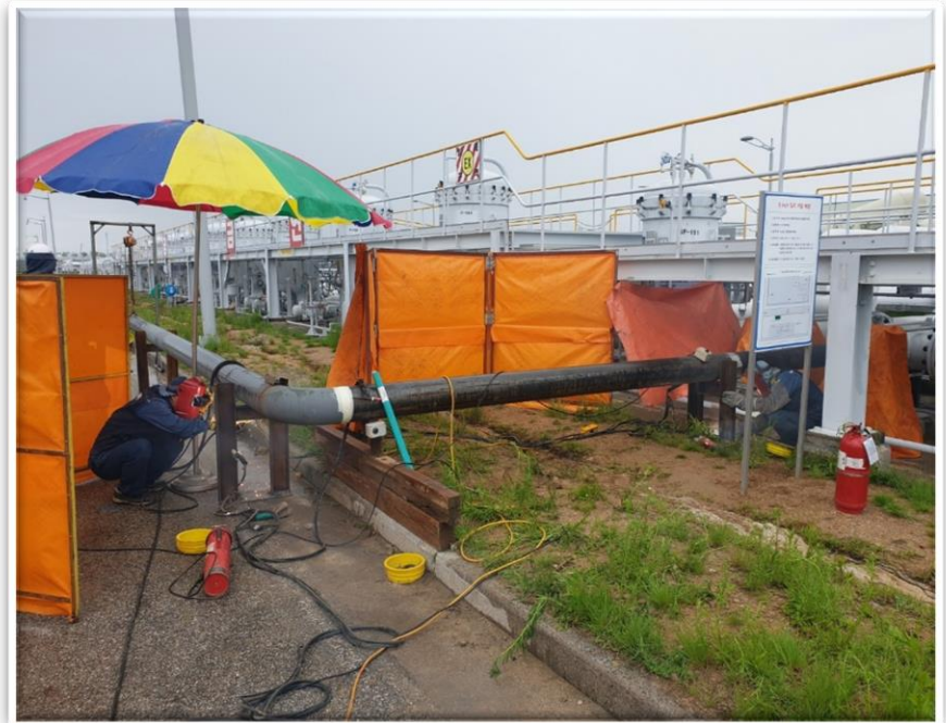
임시배관 설치 작업
